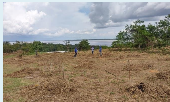
Imagem 3: Técnicos da Água de Manaus demarcando local de passagem da tubulação.
