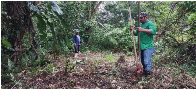
Imagem 8: Abertura manual dos berços por boca-de-lobo.
