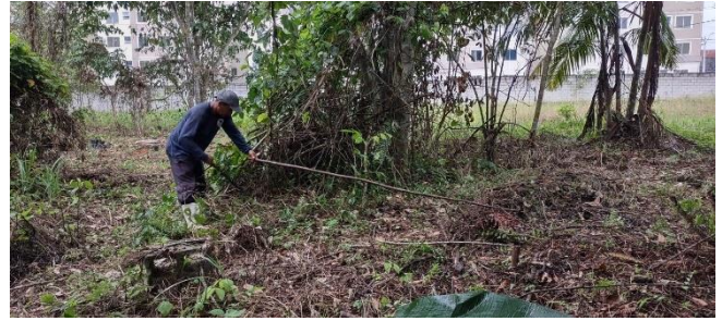
Imagem 7: Medição dos espaçamentos para abertura dos berços.
